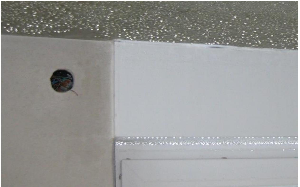
Abbildung 8: Nutzungsunabhängiger Feuchteeintrag: Tauwasserbildung auf Grund von Baufeuchte. Allein in Innenputzen und Estrich befinden sich je rund 10 Liter Wasser pro m 2 .
