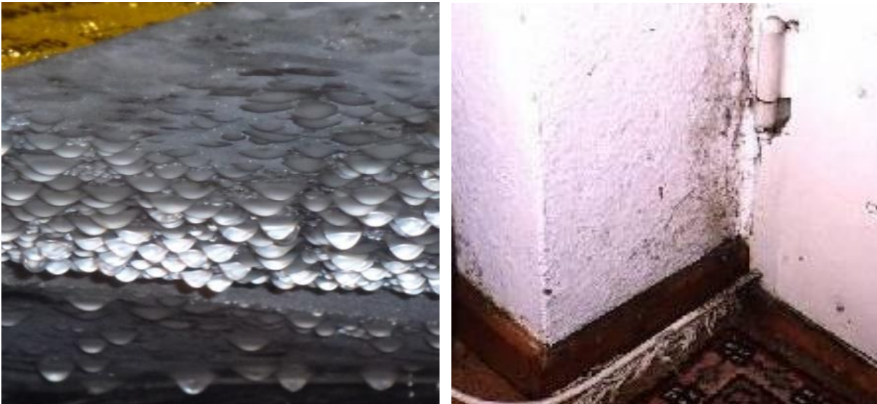
Abbildung 11: Für Schimmelwachstum wird nicht Wasser in flüssiger Form benötigt (linkes Foto), sondern es reicht eine (nicht sichtbare) erhöhte relative Feuchte aus und ein Nährstoffboden muss vorliegen
