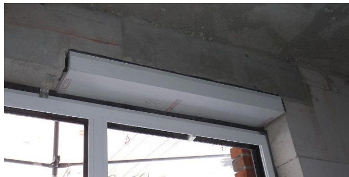
Abbildung 59: ALD als Aufsatzelement am Blendrahmen montiert, Quelle linke Abbildung ift Rosenheim
