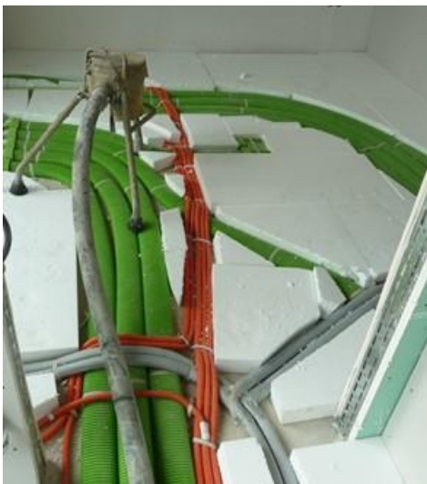
Abbildung 71: Luftleitungen müssen frühzeitig im Gebäudeentwurf geplant werden – für Reinigungszwecke muss eine Zugänglichkeit über Inspektionsöffnungen gewährleistet sein.
