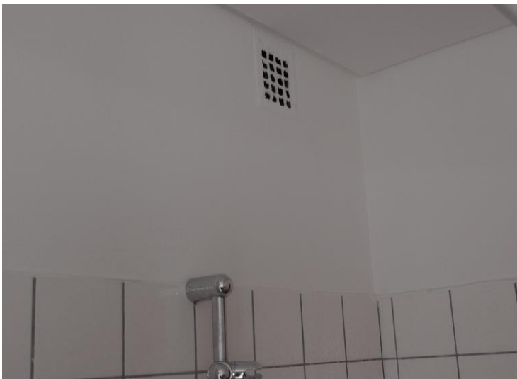
Abbildung 66: Abluftdurchlässe eines Schachtlüftungssystems
