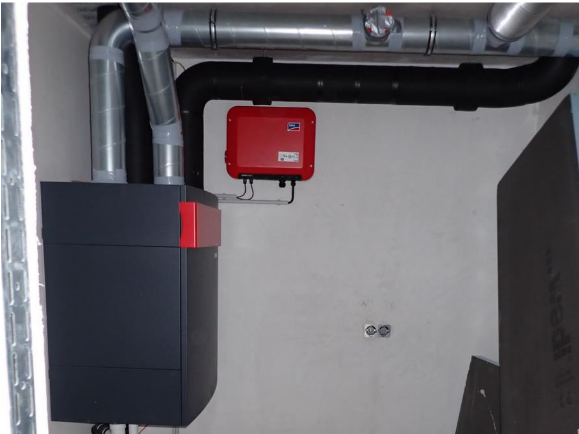
Abbildung 25: Wohnungszentrales Zu- / Abluftsystem mit Wärmerückgewinnung
