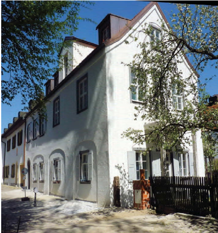
Wohnhaus Sackgasse 9 - S-W-Ansicht von Sackgasse (Foto: I. Hartert-Müller)
