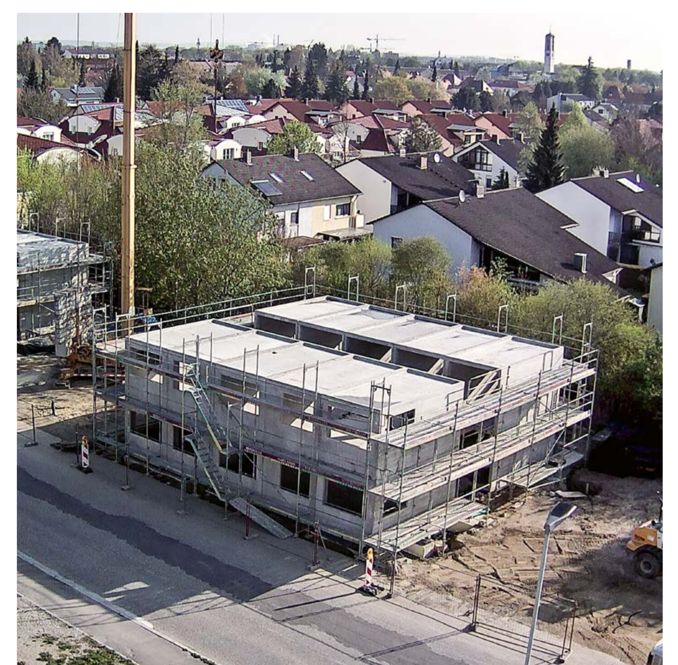
Baustelle | © GWG Architekturfotos
